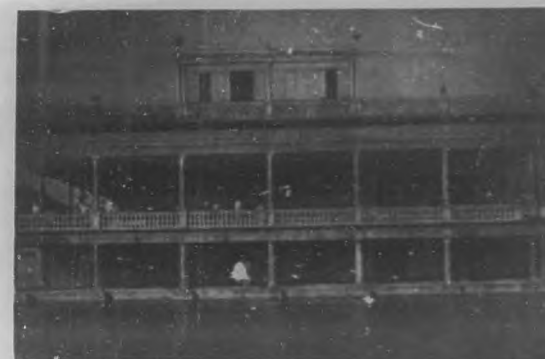
San Pedro de Macoris, (R. D.).—Vista del edificio del señor José Armentero, por la parte que da al río.
